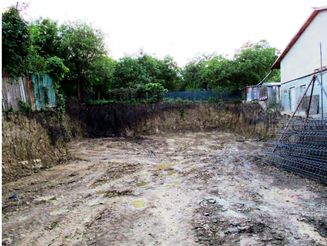
Figura 243. Deschidere în deluviu de alunecare Țicău pe strada Hotin, nr. 31; în colțul din dreapta se pot observa peste sol, deponii, iar la baza deschiderii este prezentă Argila cu Cryptomactra alterată; la 2 adâncime sub platforma săpăturii Argila cu Cryptomactra este nealterată (vizibilă la săparea unor găuri pentru piloți de susținere).
