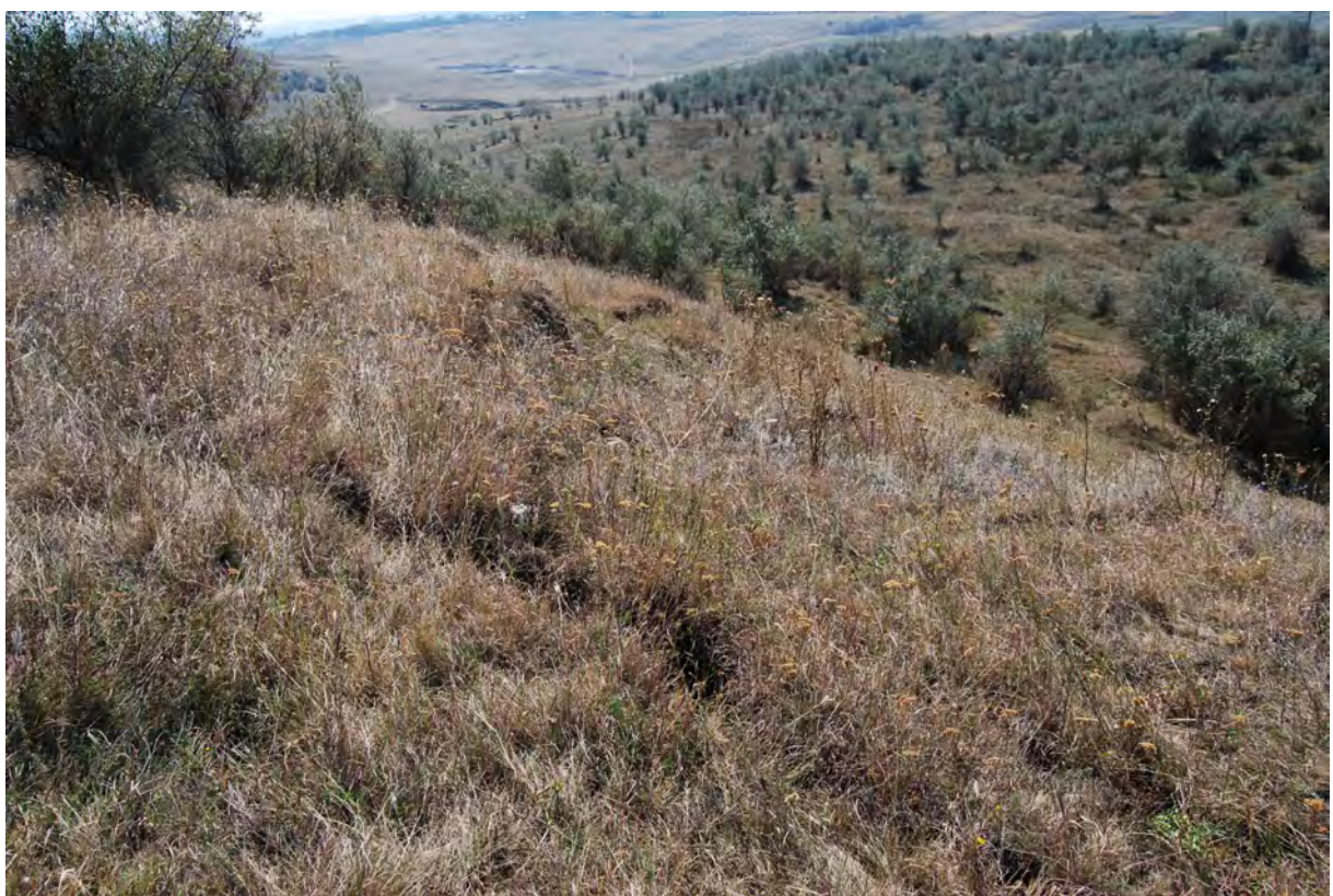
Figura 258. Fisuri în cornișa unei alunecări translaționale din malul ravenei de la Șoldănești (Figura 255).
