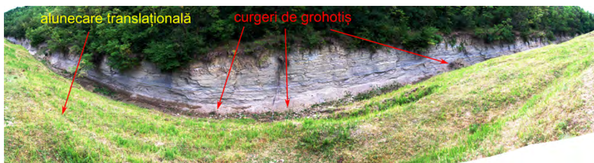
Figura 146. Cădere de grohotiș și de roci pe malul râului Cotacu, la nord de Giurgești (jud. Iași), declanșate de adâncirea râului.
