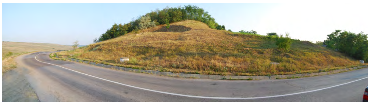
Figura 167. Carosabil și taluz afectate de alunecări de teren pe DN 29D (Botoșani-Ștefănești), la intrarea în localitatea Stăuceni (jud. Botoșani).
