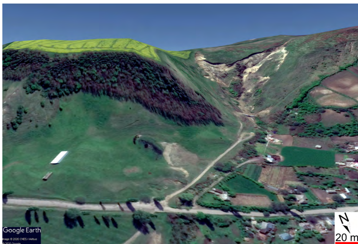
Figura 265. Reactivare translațională pe o alunecare rotațională a cornișei alunecării complexe Băiceni; imagine satelitară din arhiva Google Earth.
