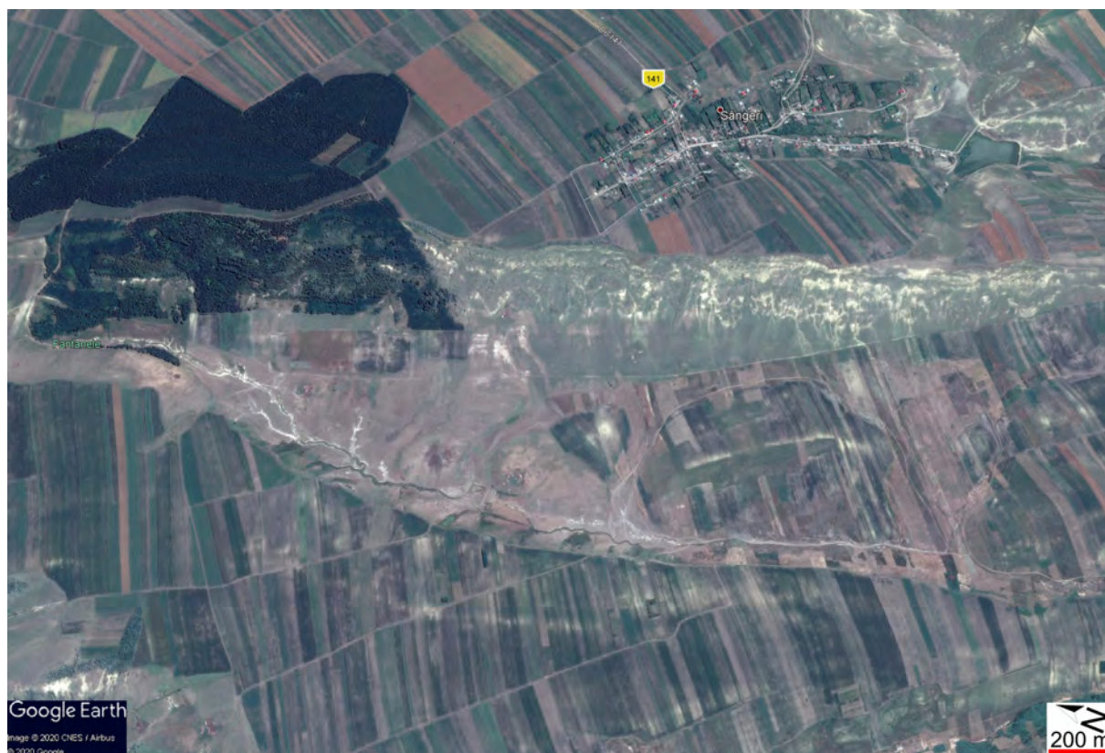
Figura 35. Alunecare complexă cu o extindere laterală de 3,3 km în bazinul Brânza Roșie, la vest de Sângești (jud. Iași); imagine satelitară din arhiva Google Earth.
