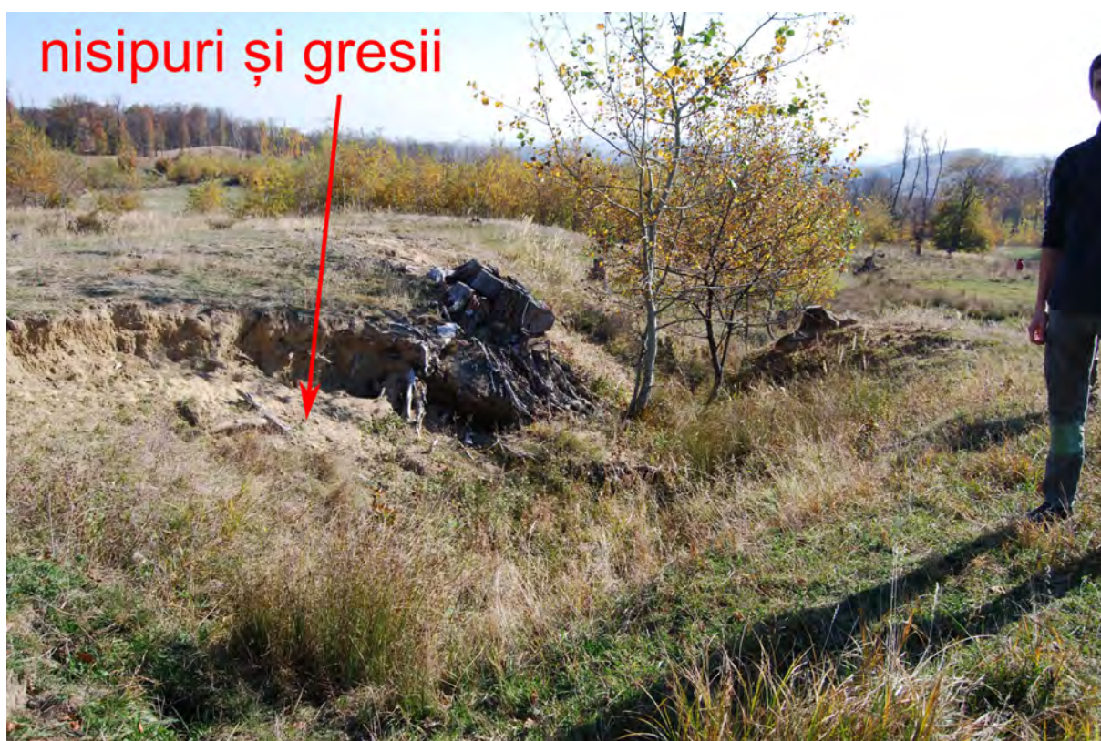
Figura 136. Roca geologică în loc (nisipuri cu intercalații de gresii) pe treptele alunecării complexe Todirești (jud. Iași); locația apare în Figura 89 cu mențiunea “roca în loc”.
