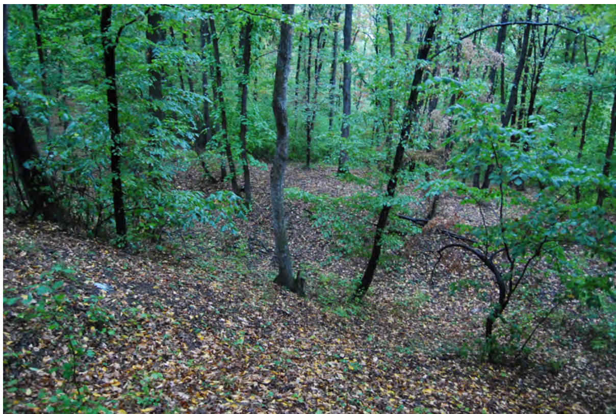
Figura 225. Alunecare recentă care afectează valul de pământ al Cetății Stâncești ( Figura 62 ), într-o zonă în care șanțul determină drenajul apelor, favorizând reactivarea cornișei.
