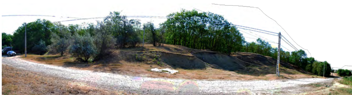
Figura 227. Baza alunecării de la nord-vest de Movila lui Burcel (jud. Vaslui), secționată de construcția drumului comunal.
