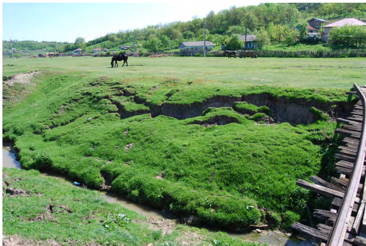
Figura 149. Alunecarea malului râului canalizat Goești, la Goești (jud. Iași).
