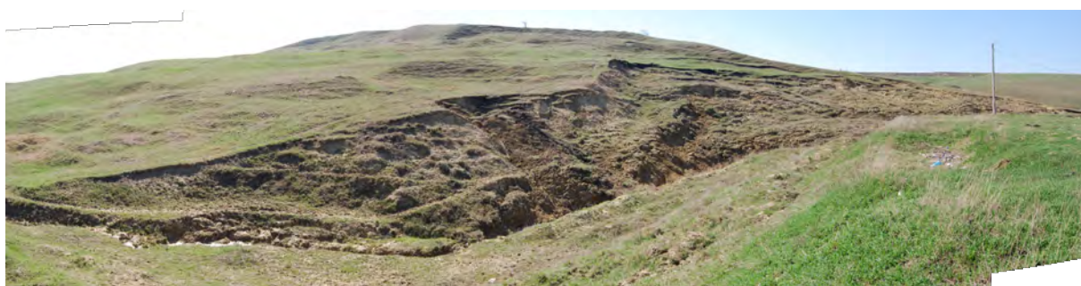
Figura 151. Alunecarea versantului Dl. Coșeri, declanșată de eroziunea canalului râului Cacăina (Zahorna), în lateralul iazului Căpitanului, amonte de Vânători (jud. Iași).
