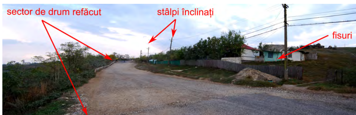
Figura 169. Alunecări de teren pe DN 29D (Botoșani-Ștefănești), în localitatea Drislea.
